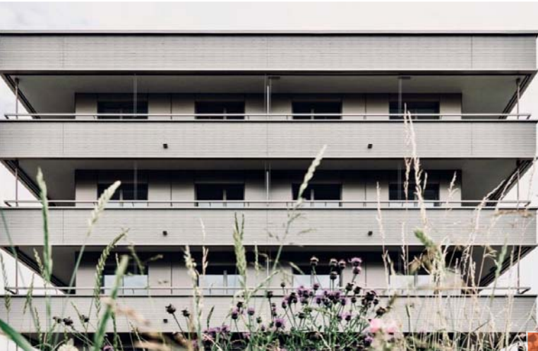
4 Immeubles dans l'écoquartier des Vergers à Meyrin. © BLSA
